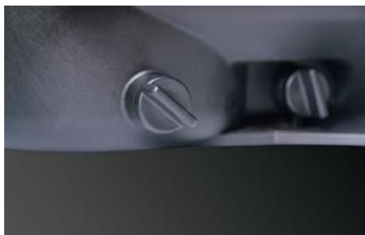
VÁLVULA DE DRENAJE
